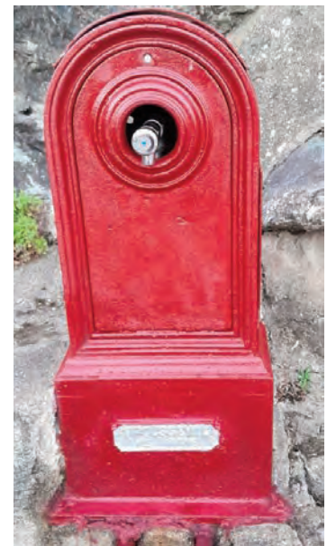
La fontaine située rue Philippe Amiel a été munie d'un bouton poussoir. Il permet à l'eau de couler à la demande.
