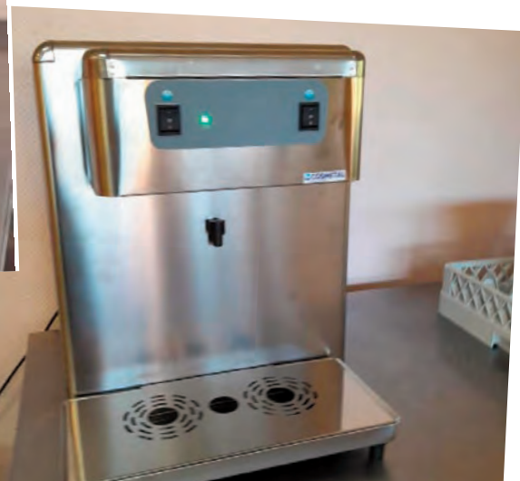
La fontaine située rue Philippe Amiel a été munie d'un bouton poussoir. Il permet à l'eau de couler à la demande.
